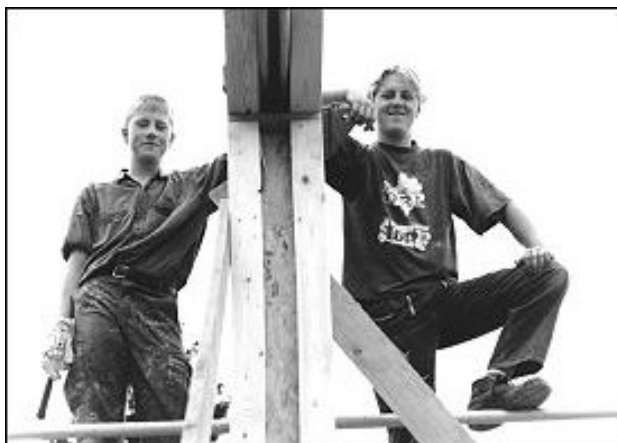
Als öffentliches Projekt erfüllt die 3,35 Mio. Mark teure Baumaßnahme in dieser entlegenen Region des Bayerischen Waldes auch arbeitsmarktpolitische Zwecke: Zwei junge Zimmerer auf der Baustelle in Finsterau (Photo: M.Ortmeier)
