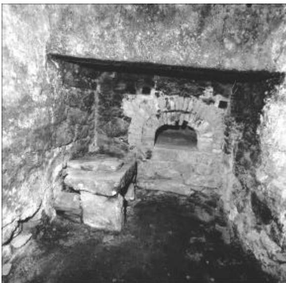
Abbildung 5: Der Brotbackofen ist in die enge Rauchkuchel eingebaut. Die Öffnungen der drei Rauchzüge, die das Ofengewölbe wärmen, sind über dem Schürloch zu erkennen. Der Steintisch, auf dem das Kochfeuer entfacht wurde, ist eines der letzten Beispiele eines offenen Herdes im Bayerischen Wald (Photo: J. Lang, 2000).
