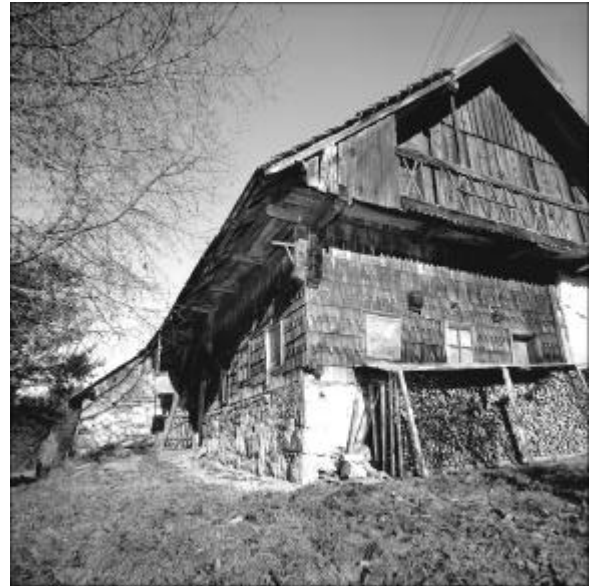
Abbildung 4: Das Schanzer-Häusl in Riedelsbach im Herbst 1999 an seinem ursprünglichen Platz. Gut erkennbar ist die Verschindelung der Stube und die Veränderung des Dachs am Giebel. Erst in den fünfziger Jahren wurde bei der Umstellung auf Ziegeldeckung der Schopfwalm entfernt.
