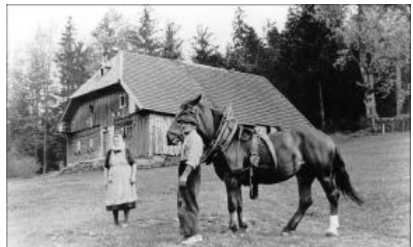
Abbildung 2: Historische Aufnahme (um 1950) eines längst abgerissenen Böhmerwaldhauses in Kainzöd bei Hauzenberg (Lkr. Passau). Das Sammeln von Bildquellen begleitet die jüngste Translozierungsmaßnahme des Freilichtmuseums Finsterau. Dieses Haus ist an der Giebelseite zugänglich. Das Dach ist am Walm mit Wellblech, über dem Wohnteil mit Biber-schwanzziegeln, über dem rückwärtigen Stall und Stadel mit Falzziegeln eingedeckt (Bildarchiv Finsterau).
